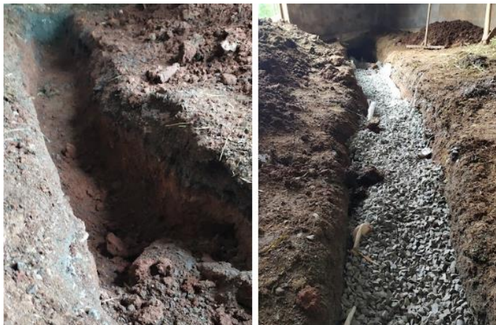
Figura 2. Dreno para diminuição da umidade da baia do cavalo
