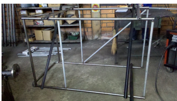
c) Travamento da estrutura para manter alinhamento
