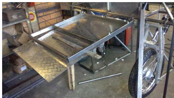
b) Detalhe da estrutura inferior do assoalho/rampa
